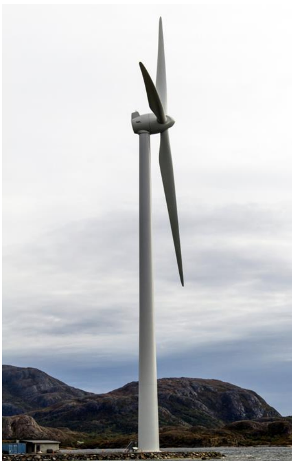
Figur 5. Ett typiskt vindkraftverk idag (direkt drivet).
